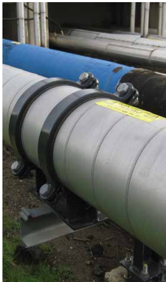
Držáky potrubí namontované na plášti zaručují jednotný teplotní profil po celé délce potrubí.
