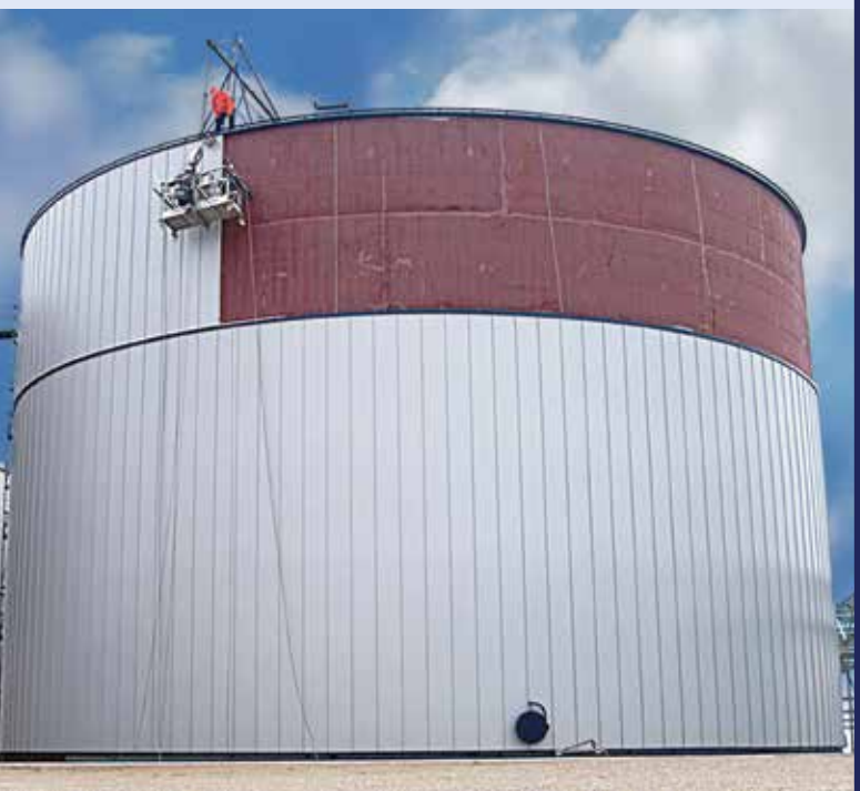
Vyloučení potřeby lešení a využití méně pracovních sil v místě instalace tvoří základ pro jednodušší plánování a vyšší bezpečnost.
