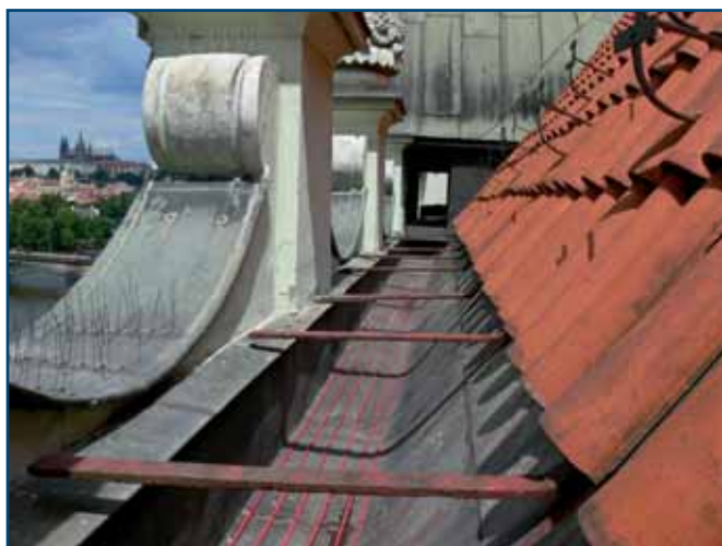
V okapech historické budovy Goethova institutu v Praze se použily kabely DEVI ™ flex DTIP-18, aby zabránily zamrznutí okapů a systém je řízen termostatem DEVI ™ reg 850.
