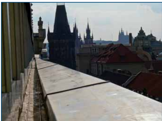
V Hotelu Kempinski v centru Prahy se instalovaly kabely DEVI ™ flex DTIP-18, aby byla zajištěna průchodnost okapů a tím se zabránilo tvorbě nebezpečných rampouchů.
