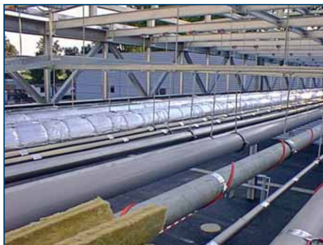
Ochrana potrubí v Olomouci proti zamrznání. Stav před zaizolováním.
