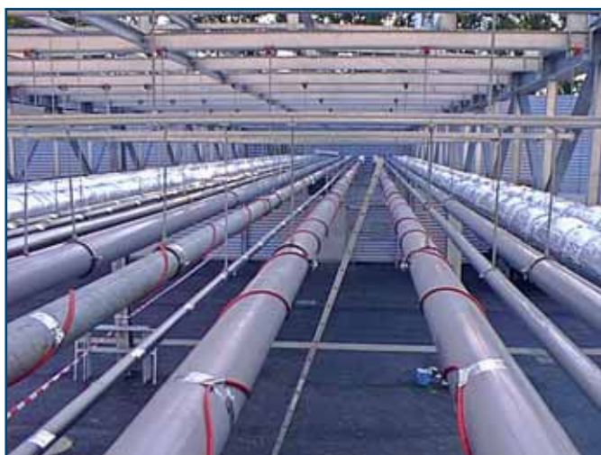
Ochrana potrubí v Olomouci proti zamrznání. Stav před zaizolováním.
