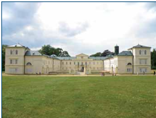
Na zámku Kynžvart se instalovaly venkovní kabely DEVI ™ flex DTCE-20 a DTCE-30, které zajišťují vytápění okapů a chrání je tak před zamrznutím. Regulace je zajištěna termostatem DEVI ™ reg 850.
