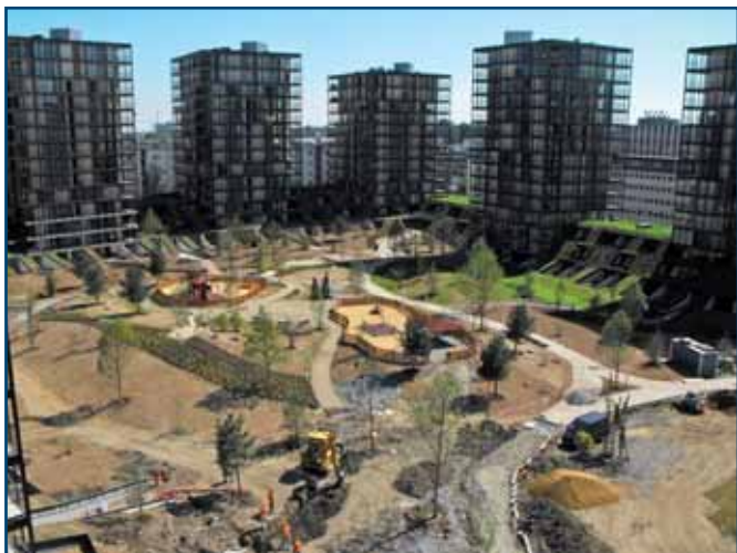
Projekt Central Park v Praze, kde se do koupelen instalovaly topné rohože DEVI ™ mat typu DSVF-150, které zajišťují temperování koupelen.
