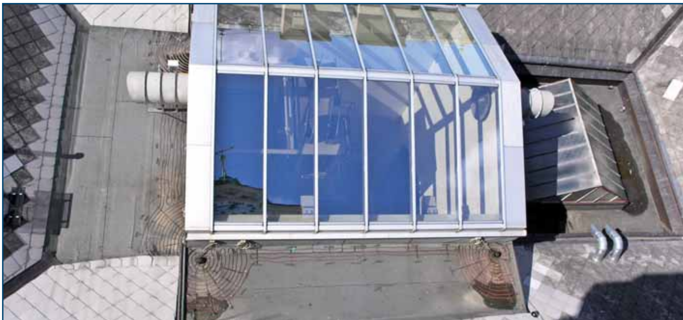
Bytový dům v Šumperku potřeboval ochránit před ledem a sněhem část ploché střechy. Namontovány byly topné kabely DEVIflex™ DTIP-18.
