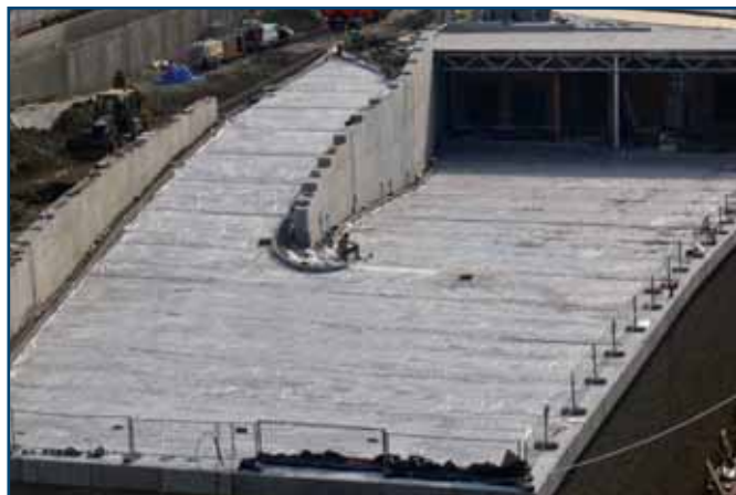
Vyhřívání nákladové rampy v nákupním centru City Park Jihlava pomocí kabelů DEVIflex™ DTIP-18.
