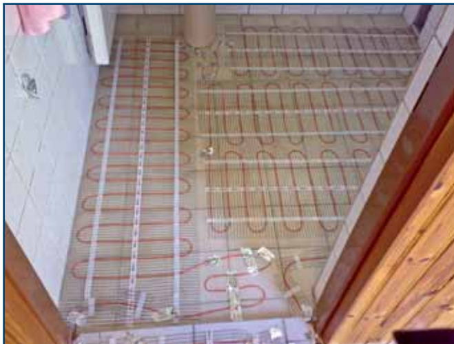
Fotografie renovace koupelny. Na stávající podlahu byly položeny topné rohože DEVI-mat™ a pro regulaci byl vybrán termostat DEVIreg™ 535.
