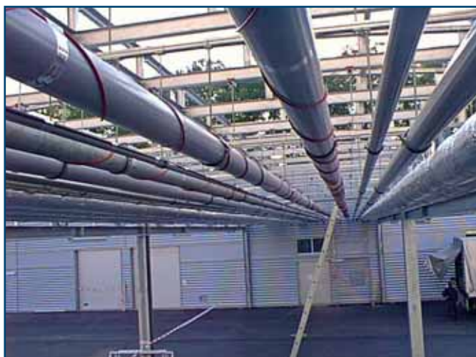
Topný kabel DEVIflex™ DTIP-18 se instaloval v Olomouci na vnější potrubí, aby jej ochránil proti zamrznání.
