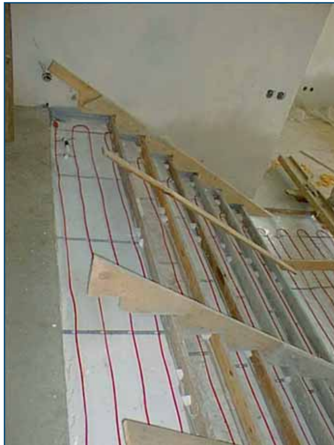
V Divadle v Šumperku se instalovaly topné kabely DEVI-flex™, které budou chránit vstupní schodiště před námrazou.
