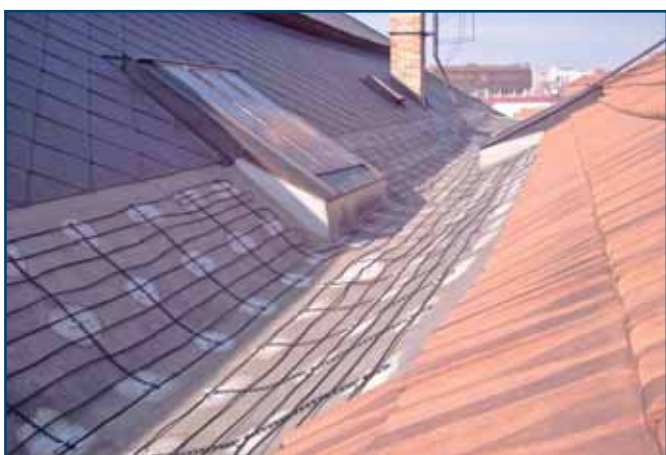
Na střeše Radnice v Pelhřimově se instalovaly kabely DEVI ™ flex DTCE-20, které brání tvorbě námrazy a hromadění sněhu v kritických místech střechy. Systém reguluje termostat DEVI ™ reg 850.
