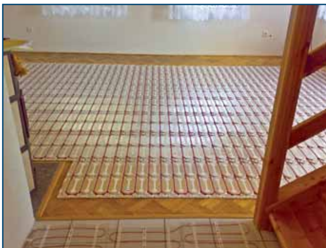
Suchá instalace topných kabelů DEVI-cell™ v rodinném domě.
